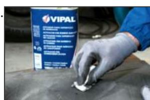
Remover o pó e realizar a limpeza com Ativador de Superfície Bufpal E.
